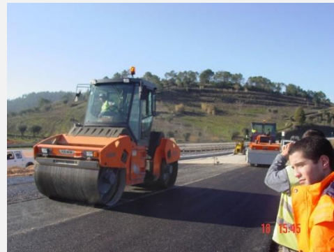
Obra de Pavimentação
